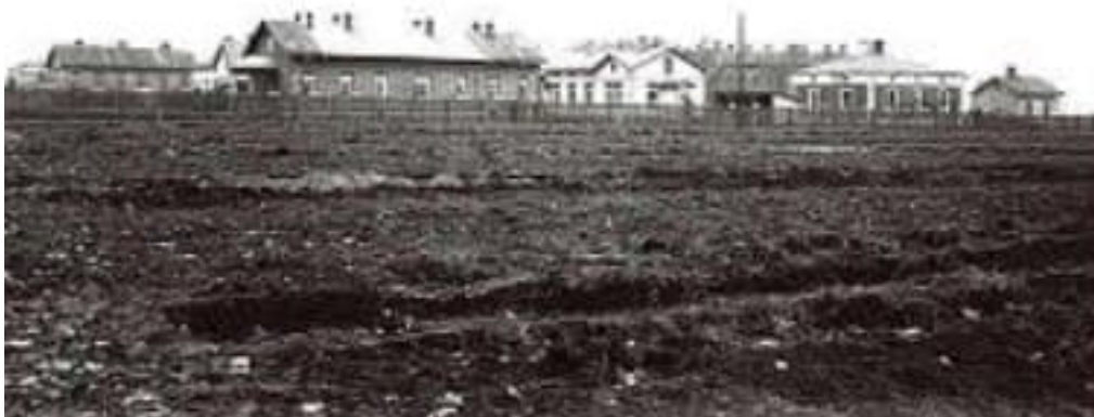
Kuva 1. Pesularakennus kuvassa toinen rakennus oikeasta reunasta katsottuna. (Kaupunginsairaalan pesularakennuksen inventointiraportti.)
