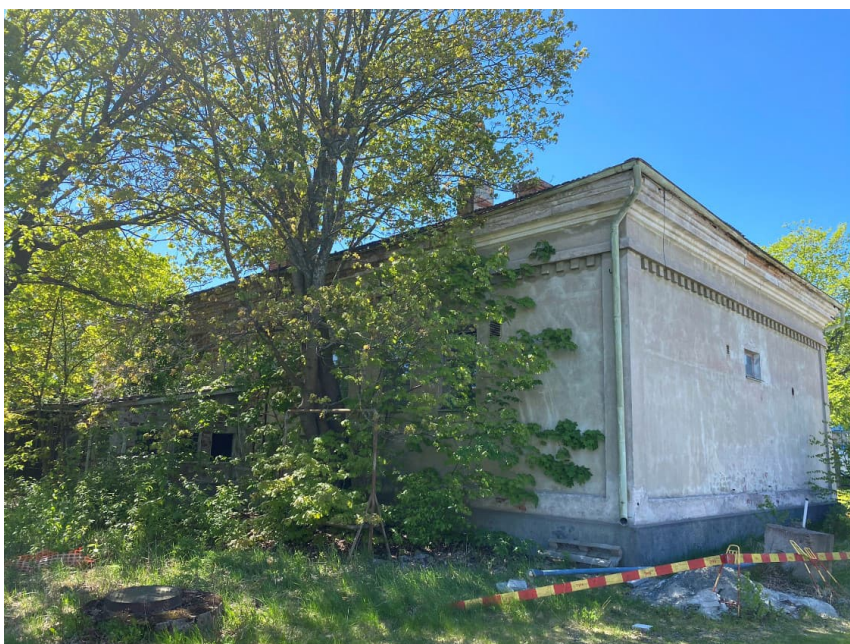
Kuva 4. Rakennuksen piha-alueen rehevöitynyt kasvillisuus.
