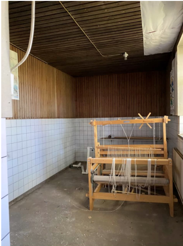
Kuva 16. Silmämääräisesti kohtuullisessa kunnossa oleva pesuhuone
